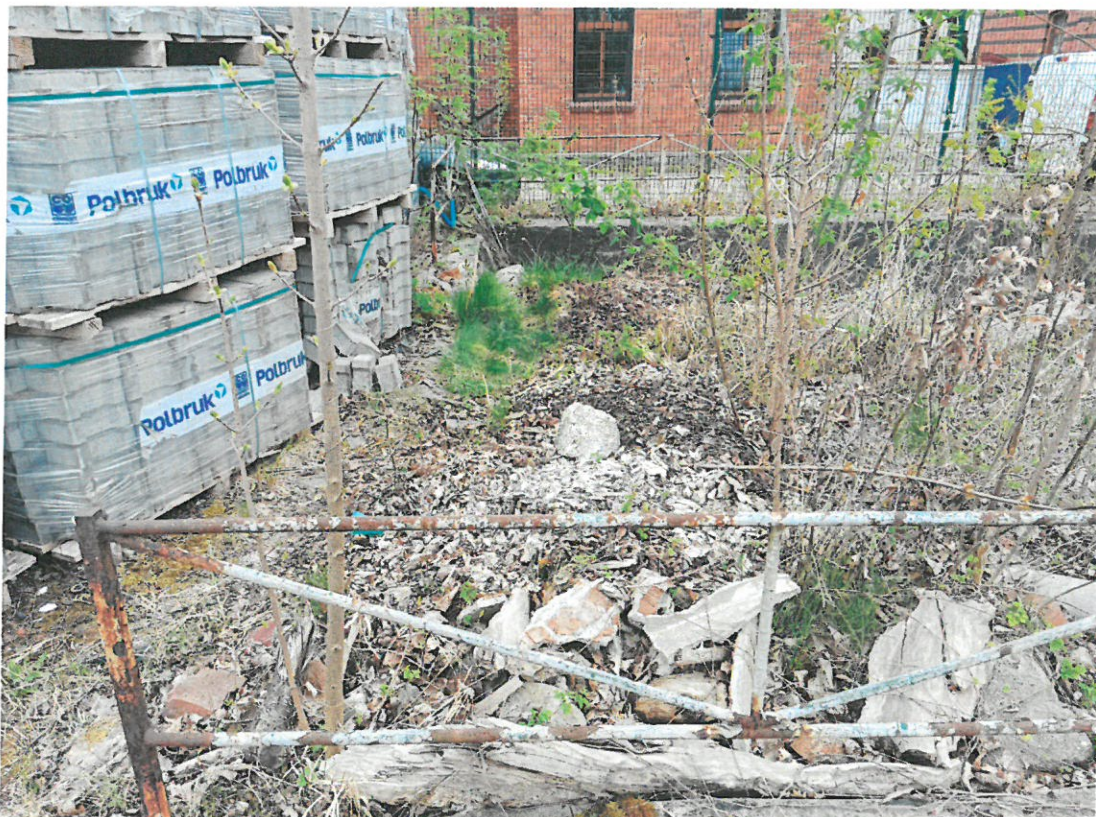
Fot. 6 Basen, porastające krzewy, barierka ochronna, ścianka basenu z betonową nawierzchnią, gruz, kostka betonowa na paletach
