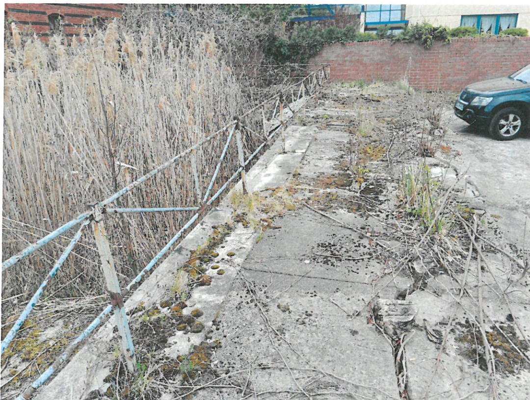
Fot. 1 Bariierka ochronna i betonowa nawierzchnia
