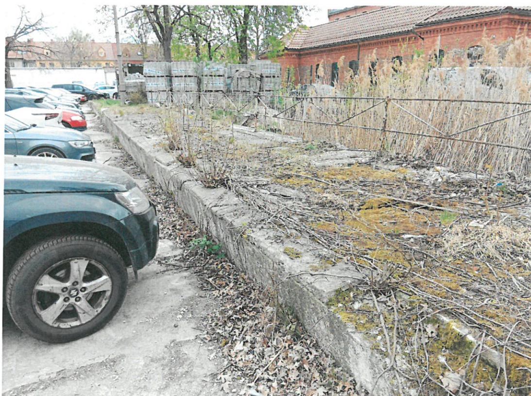
Fot. 4 Basen, porastające krzewy, barierka ochronna, murek oporowy z betonową nawierzchnią
